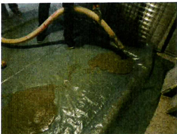
Gieten van proefvloer
