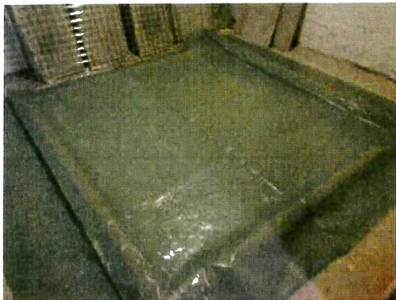
Bekisting voor proefvloer
